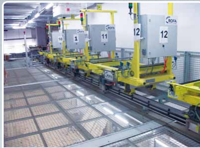
EPB-Fahrzeuge in der Zuführlinie PPC vehicles in the feeding line
