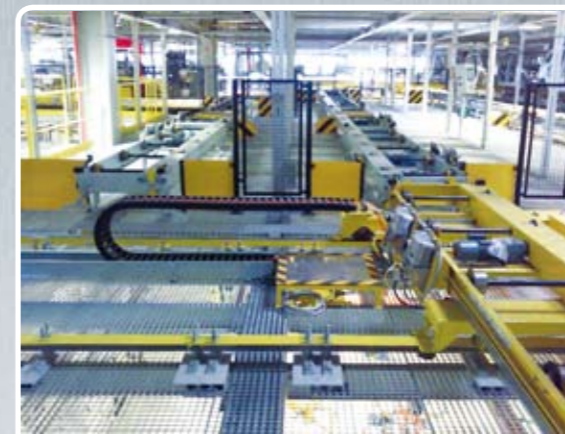
Skidanlage mit Querförderer Skid roller conveyor with lateral transporter
