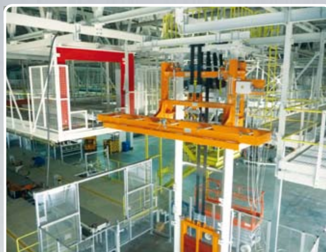
Hubstation mit Rucksackprinzip Lifting station
