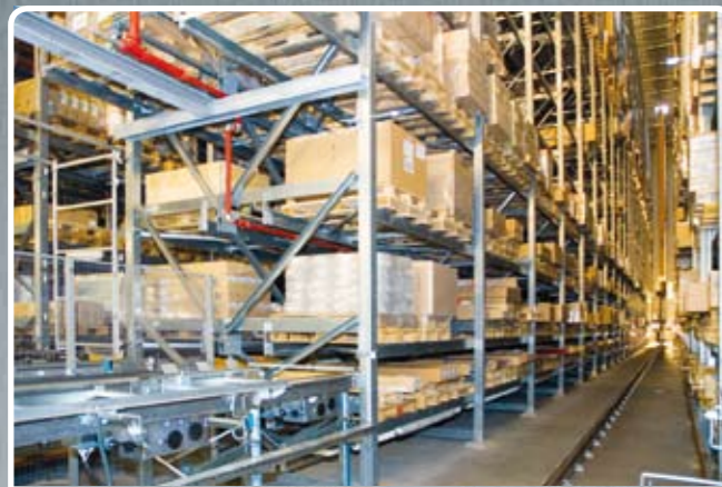
Fördergasse zur Befüllung im Hochregallager Transporting aisle in the high-bay warehouse
